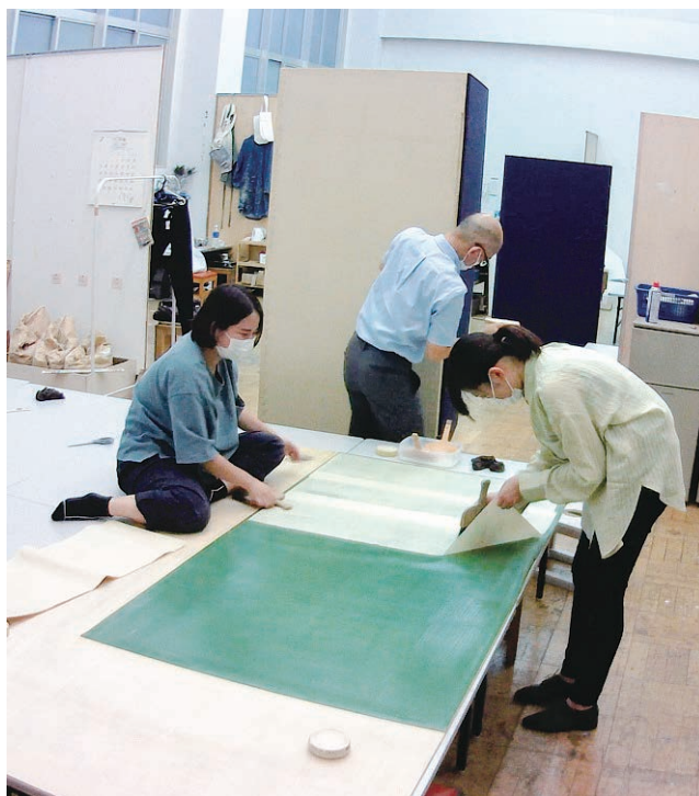
図 46-2 受け貼りをを行うと同時に屏風に濃糊を付ける
