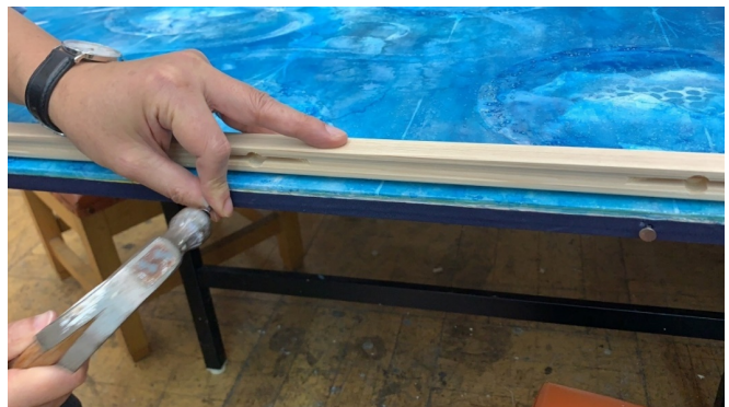
図 32 隠し釘を打つ様子
