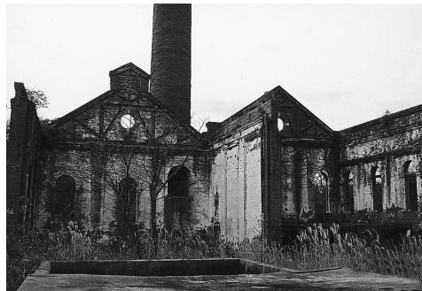
写真4；発電所の遺構(2007年1月)
