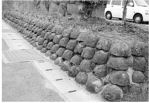
写真1；帯江鉾山の鉾滓（鉾：カラミ）を利用したのり面（2007年4月）
