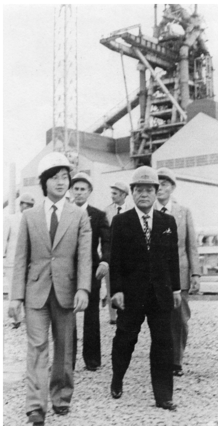
図-3 浩宮様(現皇太子殿下) 建設中の第一高炉前<1982年>
