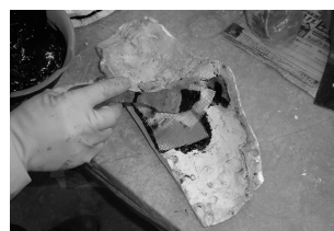
図12 ガラスクロスの貼り込み
