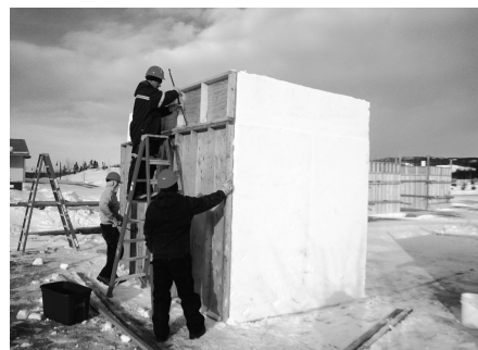
図3 型枠が剥がされ雪塊があらわれる
